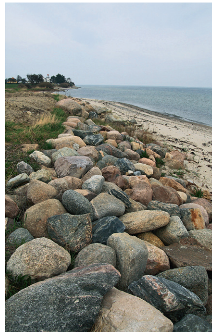
Havdiget op til Tranekær Fyr er også blevet forstærket med store kampesten, så der ikke skulle være risiko for stormflodsindbrud i den nye sø.
