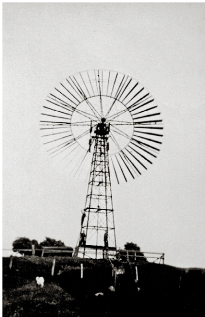
Afløseren for den hollandske pumpemølle var en moderne vindrose på et 14 meter højt stålgi-terstativ fra Scandia-fabrikken i Nyborg. Den blev opstillet i 1914 og fungerede helt frem til 1966. I 1951 blev den dog ombygget til at være en klapsejler, og i 1966 var det slut. Vindmo-toren blev pillet ned, da den elektriske pumpe-motor først var installeret. Foto: Helnæs Sogns Lokalhistoriske Arkiv.
