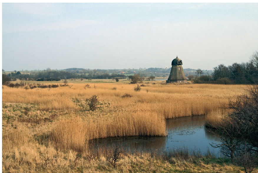
Pumpemøllen i sydvesthjørnet af Vitsø Nor er fra 1838 og ligger mellem afvandingskanalerne. Mølletypen kaldes en jorðhollænder. Møllen er en af Danmarks første vindmøller med en Arkimedes' skrue som pumpe: en spiralskrue i en tætsluttende, skrå cylinder. Når skruen drejer, løfter gevindet vand fra bunden og ud af cylinderens øverste ende. Det sort-hvide foto er taget i 1941 af geografen Einar Storgaard (1890-1981), mens forfatterens farvebillede er fra marts 2012.
