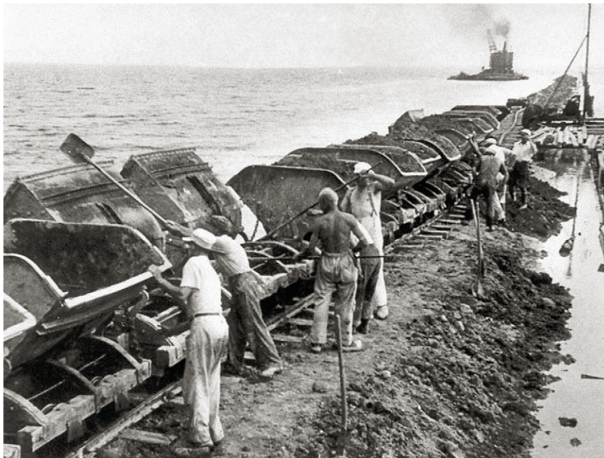
Mænd, muskler og tipvogne skabte den 13 kilometer lange dæmning i besættelsens første år. I perioder var 400 arbejdsløse beskæftiget ved det store inddæmningsprojekt, der ændrede Amager ganske gennemgribende. Foto: Tårnby Kommunes Stads- og Lokalkaliv.
