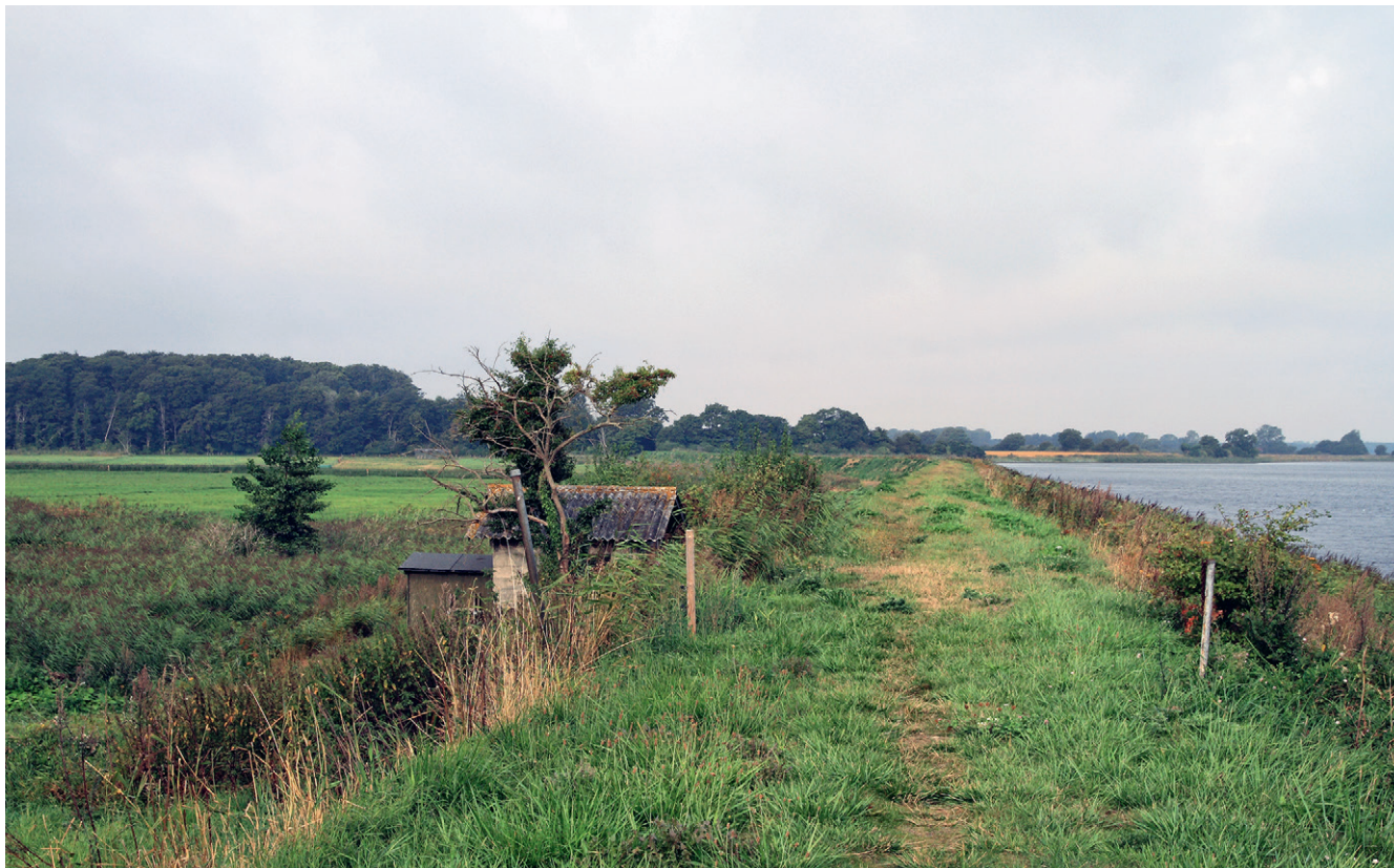
Syv år senere er alle sårene helet, og intet minder om, at den frodiggrønne dæmning var skyllet væk over flere hundrede meter i stormfloden. Umiddelbart nedenfor dæmningsfoden ligger det uanseelige pumpehus, der sørger for at holde det inddæmmede land tørt. Foto: forfatteren 31. august 2013.
