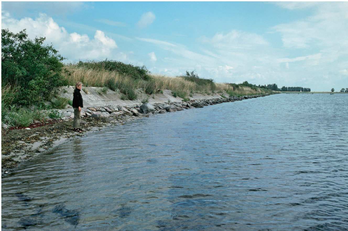
Dæmningen på tværs af Kirkevig er ca. 800 meter, og ud mod havet er den beklædt med cementplader. Siden 1872-stormfloden har der ikke været brud på den ret stejle dæmning, omend det har været tæt på nogle gange.
