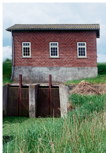
Det eksisterende pumpehus blev færdiggjort i 1929, men fungerer stadig i dag for den nordlige afvandingskanal. Foto: H.M. Markersen 1929 (sh), forfatteren 2005 (farve).
