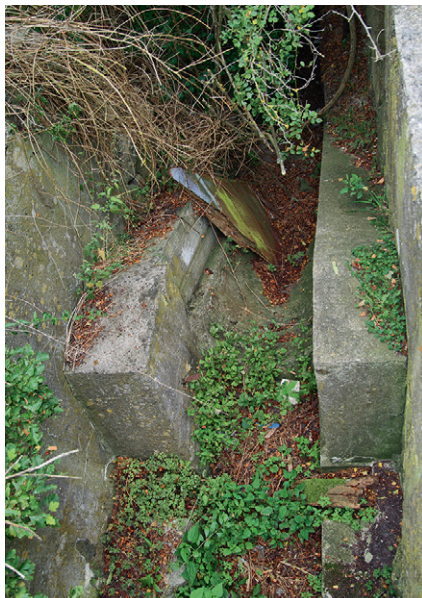
Som et vejrbestandigt minde ligger den gamle pumpekanal i cement stadig i sydenden af dæmningen. I 1958 blev der opført en ny pumpestation i røde mursten midt for dæmningen.
