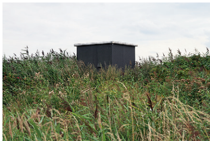
Pumpehuset ved Lille Salteng er et elendigt træskur, der er helt pakket ind i tjærepap.
