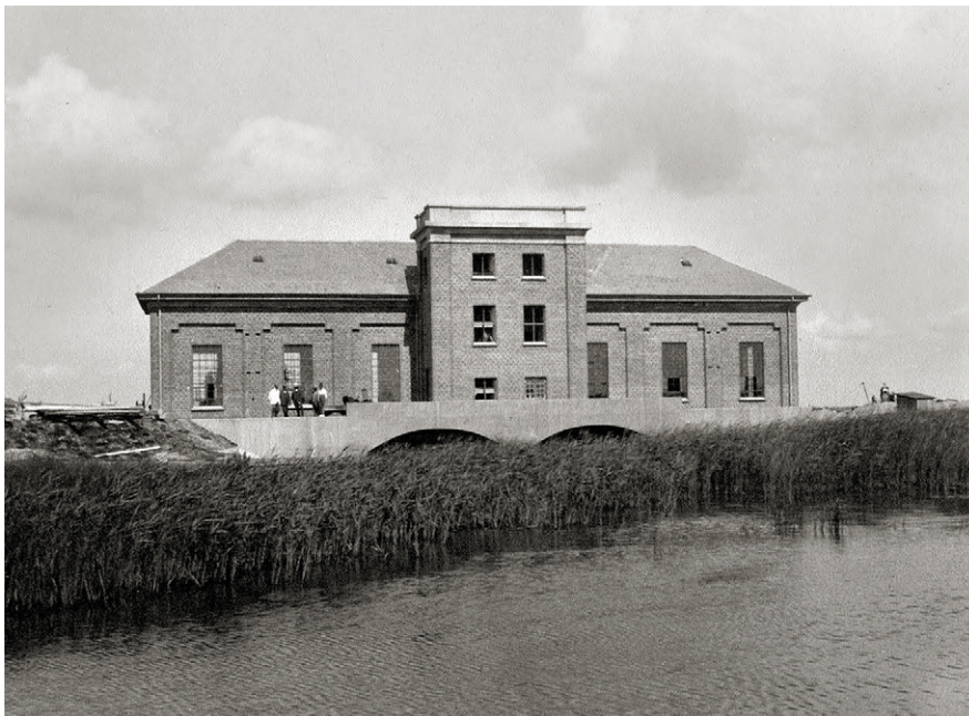
Den monumentale pumpestation i Kramnitze stod færdig i august 1927. Det arkitektoniske design havde en særlig stil, når tegningen kom fra ingeniør Markersens firma. Foto: H.M. Markersen & Søn.
