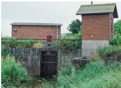
De to pumpehuse er fra henholdsvis 1939-elektrificeringen og 1954-restaureringen. Foto: 21. juli 2005.
