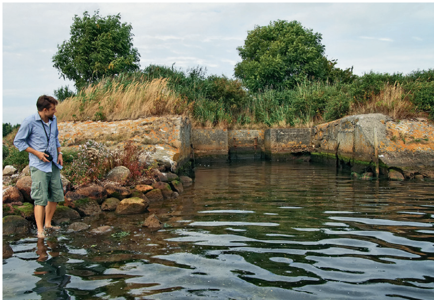
Slusen er ombygget efter ødelæggelsen i 1954, så den kun har en enkelt robust sluseport, der lukker automatisk ved højvande.
