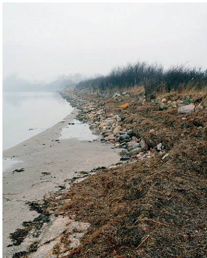
Den robuste 400 meter lange dæmning er stadig intakt, hvorimod selve slusen var defekt og utæt med saltvand pibende ind ved forfatterens besøg i februar 2014.
