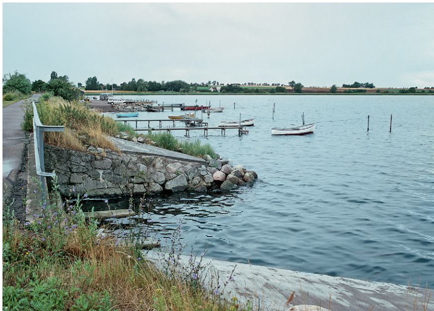
På toppen af den 1000 meter lange dæmning er der en asfalteret bilvej, men den er så smal, at to biler ikke vil kunne passere hinanden. På Storholm, hvor pumpestationen ligger, er der ud mod vigen etableret en småbådehavn.
