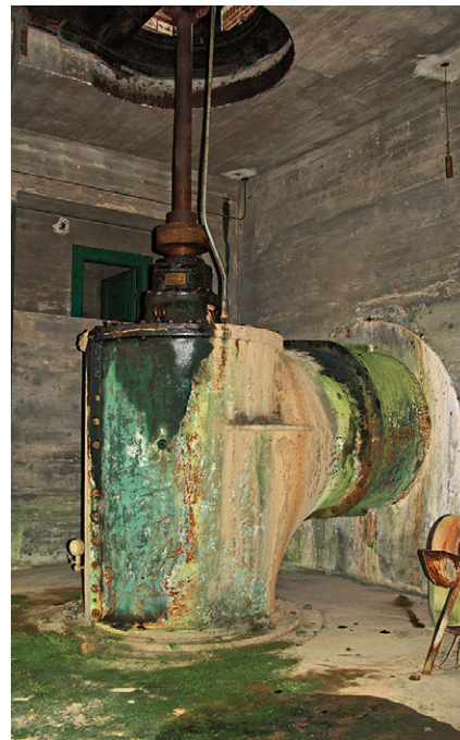
De kraftige pumper, der blev installeret i 1930'erne (tv.) i Enslev Pumpestation, fungerer stadig, omend de er noget tærede i dag (th.). Foto: H.M. Markersen (tv.) og forfatteren (th.).
