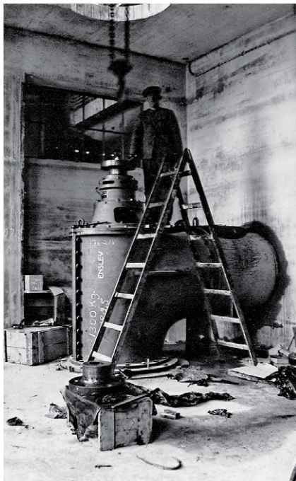
De kraftige pumper, der blev installeret i 1930'erne (tv.) i Enslev Pumpestation, fungerer stadig, omend de er noget tærede i dag (th.). Foto: H.M. Markersen (tv.) og forfatteren (th.).
