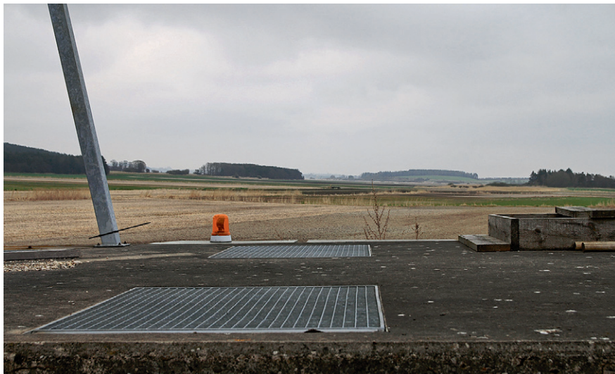
Efter rådgivning fra Hedeselskabet byggede man i 1988 endnu en pumpestation i den centrale af Kolindsund. Den skulle genskabe dræningen på de lavest liggende arealer, hvor der forekom hyppige oversvømmelser. Pumpestationen ligger der stadig og pumper, men den løste ikke problemerne.
