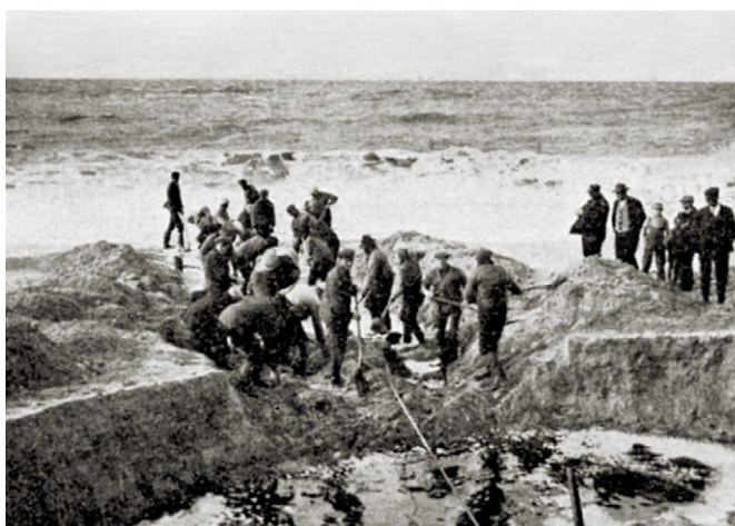
Det historiske øjeblik blev foreviget, da et hold jordarbejdere gravede en smal rende gennem den yderste del af stranden ud for det restaurerede og udvidede sluseanlæg i Thorsminde. Billedet til venstre blev taget 31. oktober 1931, kl. 14, netop som forbindelsen mellem hav og fjord er skabt. To timer senere havde det udstømmende fjordvand allerede skåret udløbet op til en betydelig bredde. Billedet til højre viser udløbet samme dag kl. 16. Fotos: Hedeselskabets Tidsskrift 1931.
