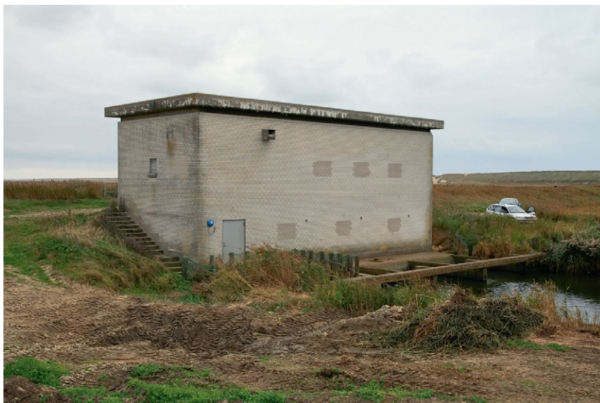
Pumpestationen ved Fjordshale hører ikke til de arkitektonisk mest charmerende i det danske afvandingslandskab. Inde i denne grå klods af et hus står der to elektriske pumper, der tilsammen kan løfte 4500 liter vand i sekundet fra Ramme Å og op over dæmningen og ud i fjorden.
