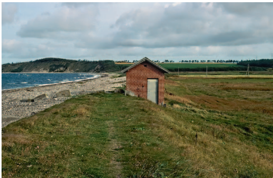
Vandstanden i Nissum Bredning står højere end markerne inde i Odby Sø, så uden dæmningen og pumpen ville den gamle sø genopstå af sig selv.
