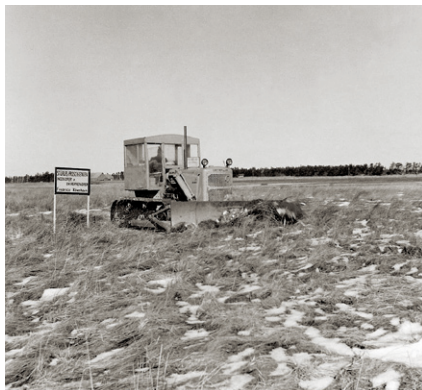
Det første spadestik til kanaliseringen af Skjernå blev taget med en bulldozer i marts 1962. Foto: Hedeselskabet.
