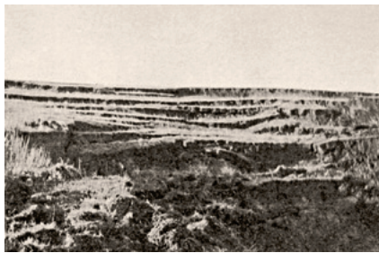
Manglende jordbundsundersøgelser i Væth Enge gav ubehagelige overraskelser og ekstra regninger. Nogle steder var der nærmest flydejord, så græsmarkerne skred ud over større arealer, når der blev gravet. Foto: Hedeselskabet, 1925.
