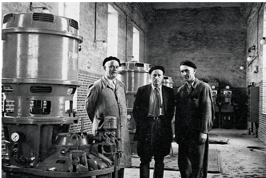
Pumpestationen på Attrup-Øland dæmningen var dimensioneret til at tage imod meget store vandmængder. Afvandingen omfattede et samlet område på ca. 12.500 hektar, hvorfra alt overfladevand skulle pumpes ud i Limfjorden. De enorme vandmængder førtes frem til pumpestationen gennem ca. 100 kilometer vandløb og kanaler samt 10 kilometer nedgravede rørledninger. Der blev installeret tre lige store pumper (nederste billede), hver med en 180 hk elektromotor og en lukket propelpumpe. Ved en løftehøjde på halvanden meter ydede hver pumpe 5,1 kubikmeter vand i sekundet, og det blev til ca. 1,3 millioner kubikmeter i døgnet. De nuværende pumper stammer dog fra 1995. Foto: H.M. Markersen & Søn, Rødby.
