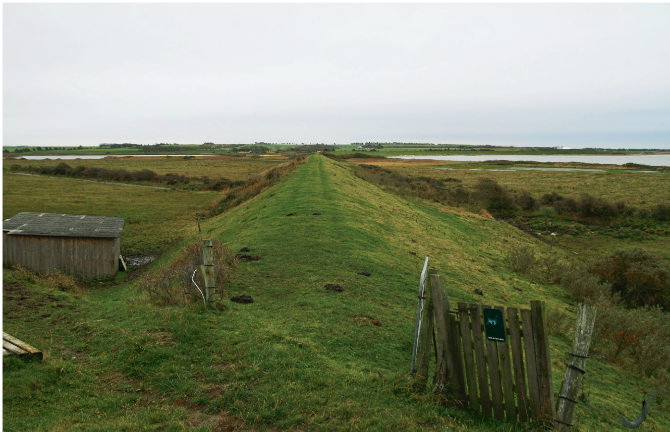
Ved dæmningsbyggeri efter 1882 blev Flade Sø adskilt fra Ørum Sø, og denne dæmning ligger der stadig. Det er Flade Sø til højre.
