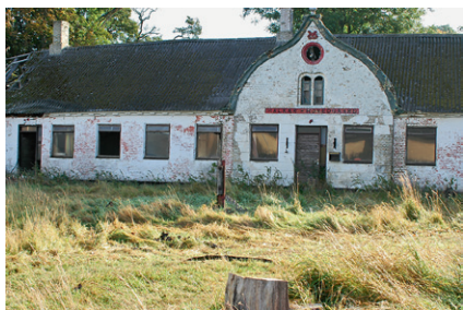
Halkær Hovedgård er første gang nævnt i 1380. Hovedbygningen på billedet var opført i 1901, men efter årelang misligholdelse blev den nedrevet i 2003. Hovedgårdens marker indgik i jordfordelingen, der banede vejen for søprojektet. Foto: Peter A. Larsen.
