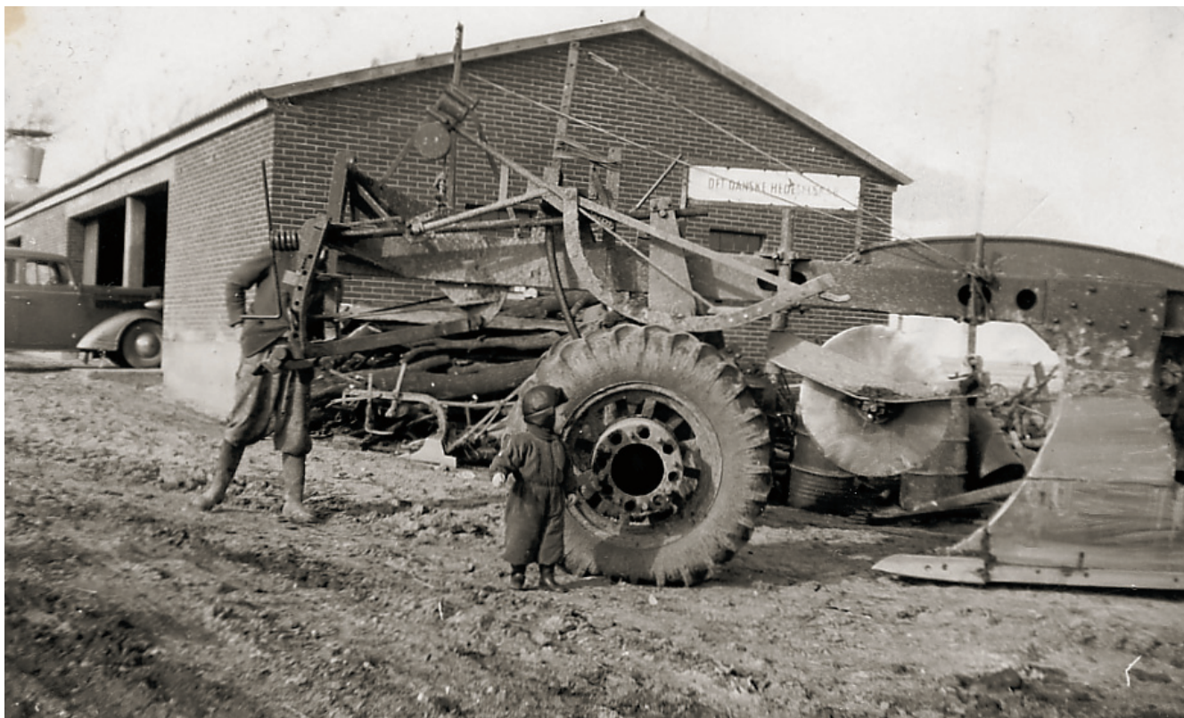
Boulundploven fra den danske fabrik af samme navn var Hedeselskabets stolthed og blev betragtet som lidt af et mirakelredskab. På det aflange hvide skilt øverst på ploven stod der »Det danske Hedeselskab«, så ingen kunne være i tvivl om ejeren. Ploven står her parkeret foran maskinhuset på Enggård, hvor Jens Rokkjær og en lille nevø inspicerer den. Foto: udlånt af Karen Rokkjær.
