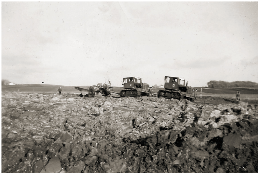
To bæltetrucke traktorer med hver 70 Hk skulle der til for at slæbe den store plov gennem den jomfruelige fjordbund. Ploven gik ned til 80 cm og efterlod en fure på 125 cm, men det kneb med farten, så ofte blev furerne blot stillet på højkant. Det var noget af et arbejde at jævne ud efter en sådan pløjning, og ikke alle traktorer havde et fortøj, der kunne holde til den hårde medfart. Foto: udlånt af Karen Rokkjær.
