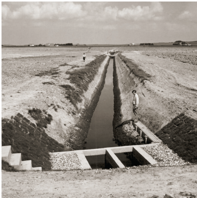
Den snorlige centralkanal blev gravet bredere og uddybet (billedet til venstre), så de nye Lykkegård-pumper kunne tage fat og pumpe vigen tør. Udenfor dæmningen (billedet til højre) var der allerede i 1954 et pænt stykke bevokset »forland«, så der måtte også her graves en afløbskanal ud til Limfjorden. Begge fotos er fra sommeren 1954, hvor udtørringen netop var gennemført, og kultiveringen kunne begynde. Foto: Hedeselskabet.
