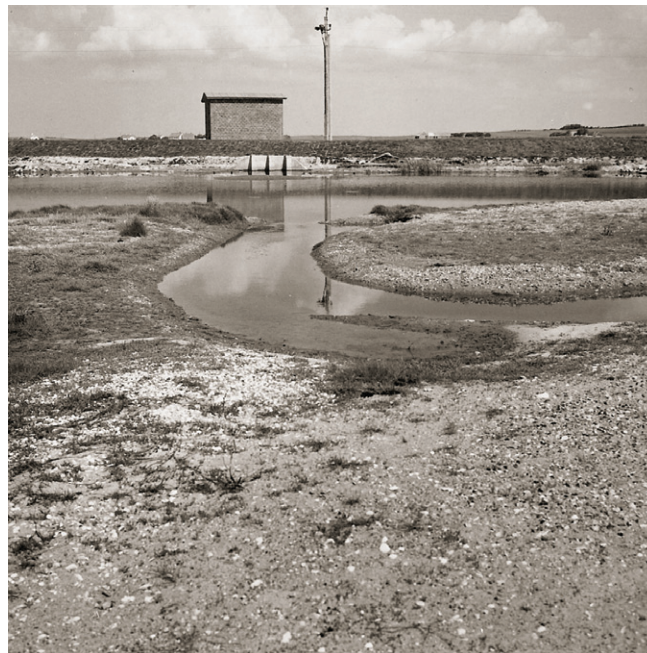
Den snorlige centralkanal blev gravet bredere og uddybet (billedet til venstre), så de nye Lykkegård-pumper kunne tage fat og pumpe vigen tør. Udenfor dæmningen (billedet til højre) var der allerede i 1954 et pænt stykke bevokset »forland«, så der måtte også her graves en afløbskanal ud til Limfjorden. Begge fotos er fra sommeren 1954, hvor udtørringen netop var gennemført, og kultiveringen kunne begynde. Foto: Hedeselskabet.
