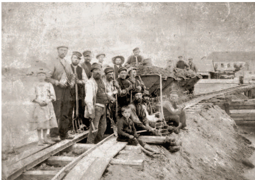
Dette enestående billede fra bygningen af dæmningen tværs over Glomstrup Vig er optaget før 1874. Man får et levende indtryk af de farverige »børster« – og børn -, der knoklede med at slæbe jord sammen til landvindingsprojektet. Foto fra bogen »Thissinghus i ord og billeder 1858-2008.«
