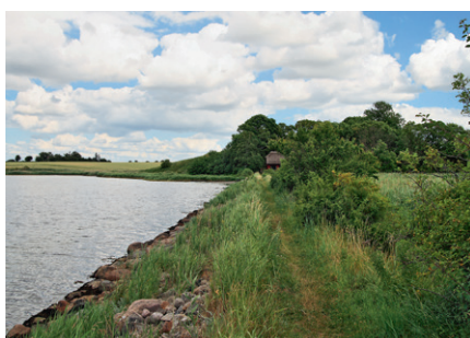
Dæmningen mod Skælskør Inderfjord er en 220 meter lang jordvold, der er forstærket på ydersiden med granitsten og bevokset med græs. En sti er slået i græsset. Pumpemøllen er væk, men der ligger rester af et fundament og en rusten vandsnegl ved højvandslusen. Foto: (s/h) Ejnar Storgaard 1941, (vandskruen) forfatteren 20. juni 2005.
