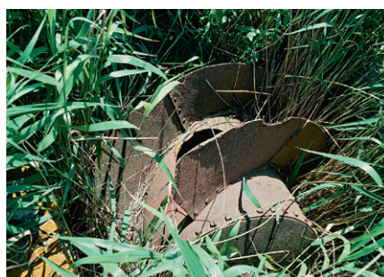
Dæmningen mod Skælskør Inderfjord er en 220 meter lang jordvold, der er forstærket på ydersiden med granitsten og bevokset med græs. En sti er slået i græsset. Pumpemøllen er væk, men der ligger rester af et fundament og en rusten vandsnegl ved højvandslusen. Foto: (s/h) Ejnar Storgaard 1941, (vandskruen) forfatteren 20. juni 2005.
