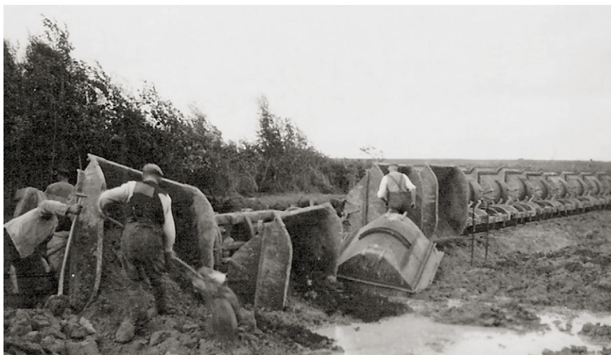
En ekstra dæmning måtte bygges over en kortere strækning tværs over Kong Mose, fordi der var seks meter ned til fast bund. Tipvognene måtte køre op til 100 kubikmeter jord ud på dæmningen for hver løbende meter. Foto: Hedeselskabet.
