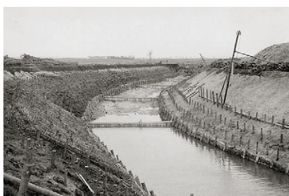
Indløbet fra KØng Mose til Fuglebæk Pumpestation var ikke nogen nem opgave at etablere. De skrå sider truede konstant med at styrte sammen, så de måtte stabiliseres med faskiner i flere etager. Fotos: Hedeselskabet (s/h) og forfatteren (farve).
