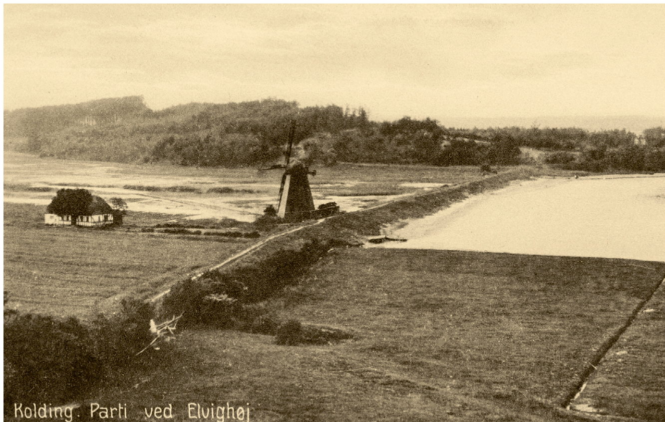
Den 300 meter lange dæmning over Eltang Vig blev opført i 1872, og få år senere blev der opført en hollandsk pumpemølle, som sænkede vandstanden til næsten en meter under daglig vande. Fjordbunden blev omdannet til en hængesæk, og det lykkedes at tilså den bløde bund med græsser, men kun halvgræsser af meget ringe kvalitet slog an. Bunden kunne knap bære mennesker eller dyr. Billedet er fra ca. 1895 og optaget fra Elvighøj på sydsiden. Foto: udlånt af Kolding Stadsarkiv.
