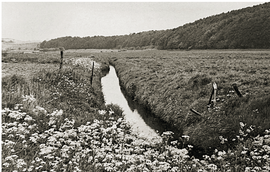
Ned gennem de dræned enge i vigen løb den centrale afvandingskanal, der førte vandet frem til dæmningen, som billedet er taget fra. På de sidste 10 meter frem til pumperne var kanalen rørlagt. Billedet er formentlig optaget i sommeren 1956. Foto: Tove Boserup, 1956.
