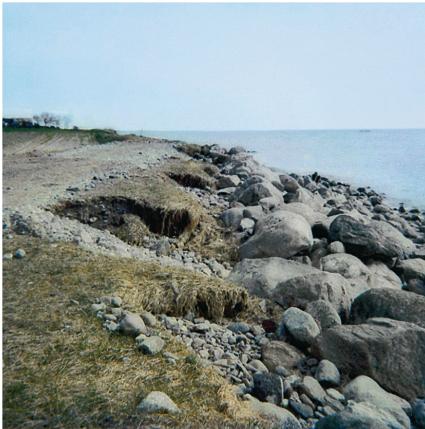
Dæmningen viste sig at være fejlplaceret. I iveren efter at få så meget land med som muligt havde man fået lagt den for langt ude. Havet gnavede derfor uafslutteligt løs, især i den østre ende, hvor dæmningsbrud truede flere gange. Årstallet for billedet er ikke kendt, men det antages at være en gang i 1960'erne. Foto: Lysabild Sognearkiv.
