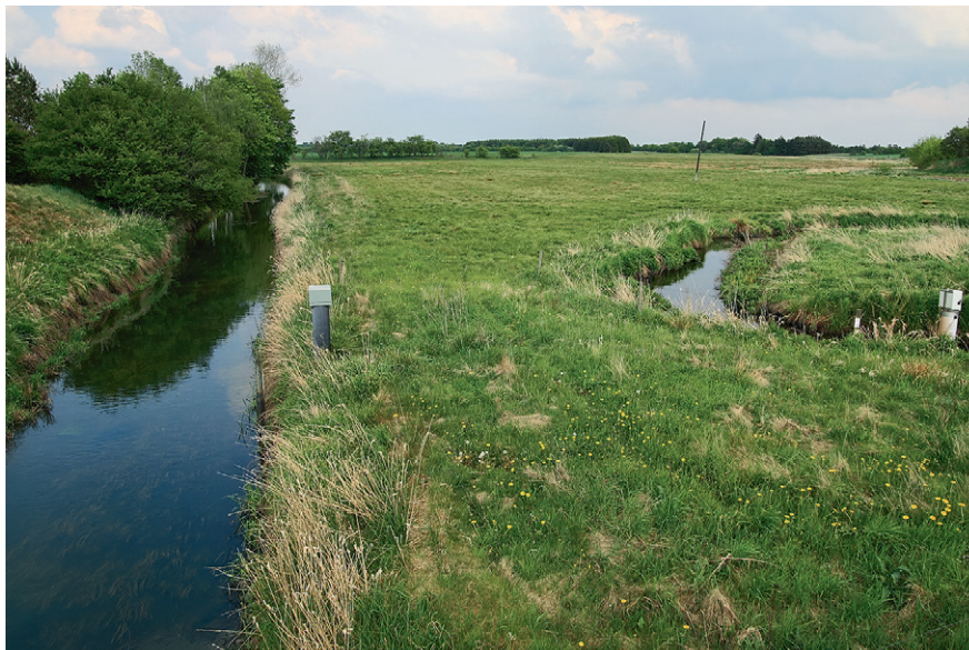
Almstrup Kanal (til venstre) løber parallelt med Bjørndrup Mølleå (til højre) over knap en kilometer, før de to vandløb løber sammen vest for jernbanen ved Bajstrup. Jo længere nedstrøms, man forener to vandløb, desto større fald får man og dermed kraftigere afvanding. Bemærk den tydelige forskel i vandspejlets højde i de to vandløb.
