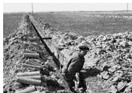
Millionstøtten fra staten var givet efter en lovgivning til bekæmpelse af arbejdsløshed, men da der var fuld beskæftigelse ved indgangen til 1960'erne, fik Gyldensteen Gods dispensation til at erstatte mænd med maskiner. Fotos: Hedeselskabet (øverst), Bogense Lokalhistoriske Arkiv (nederst).
