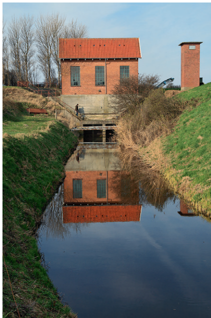
Pumpestationen ude ved Skinholm er fra den store renovering af afvandingsanlægget i slutningen af 1940'erne. Arkitekturen er den klassiske for Hedeselskabets design – funktionalisme i røde mursten og rødt tegltag.
