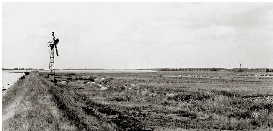
Udpumpningen blev forstærket med en klapsejler på Lammesø-dæmningen ud til Galthoved. Den er installeret efter de store oversvømmelser i 1921. På et tidspunkt efter 1946 er den nedtaget og erstattet af en simpel pumpebrønd i et par cementrør (foto s. 199, Stenak 2005). Foto: Einar Storgaard, 1941.
