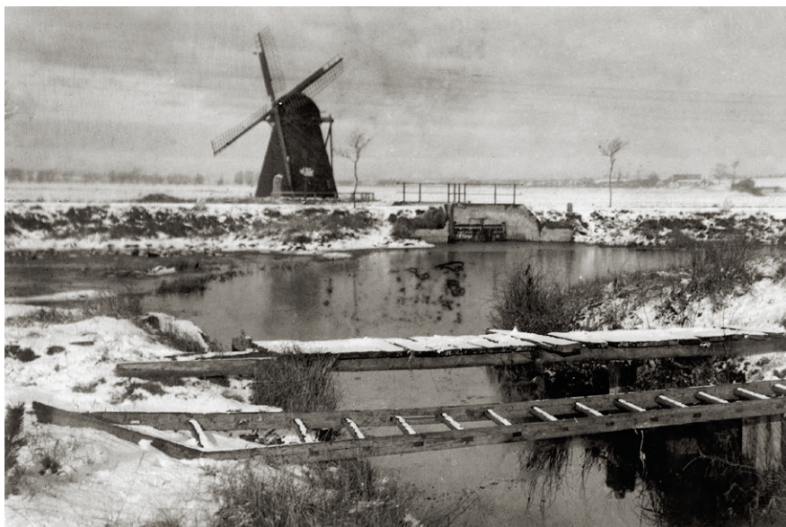
Denne pumpemølle ved Møllemadegrøften fungerede i årtier som eneste kraftkilde til tørholdelse af den inddæmmede strand. Hvornår den præcis er opført på dette sted, vides ikke, men den blev dømt ineffektiv og nedtaget i 1924-26. Foto: Udlånt af Kerteminde Byhistoriske Arkiv.
