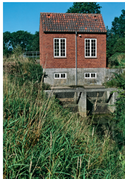
Pumperne i det nybyggede pumpehus oppe ved Søborggård kunne startes i 1947. De kunne løfte henholdsvis 600 og 300 liter vand i sekundet, så nu var det muligt at tørlægge søen mere effektivt end tidligere.
