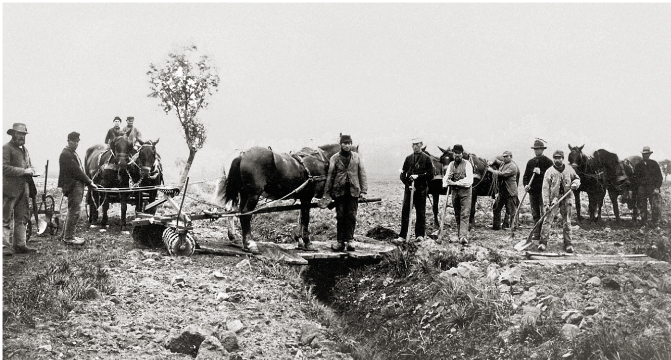
De mange kilometer kanaler og grøfter blev gravet med håndkraft, og jorden kørt bort med hestekræfter, hvorefter der blev tromlet og jævnet ud. Arbejdsstyrken var i perioder oppe på 150 mænd. Foto: fra Petersen & Meyhoff 1986.
