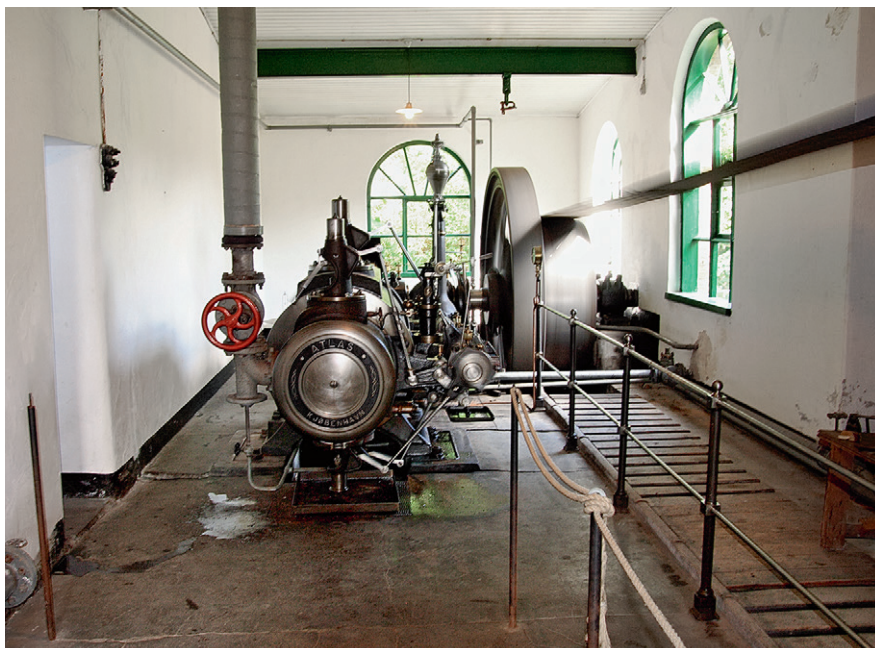
Dampmaskinen fra 1901 med tilhørende vandsnegl er stadig funktionsdygtig, og den kører til ære for gæster torsdag og søndag i sommersæsonen.
