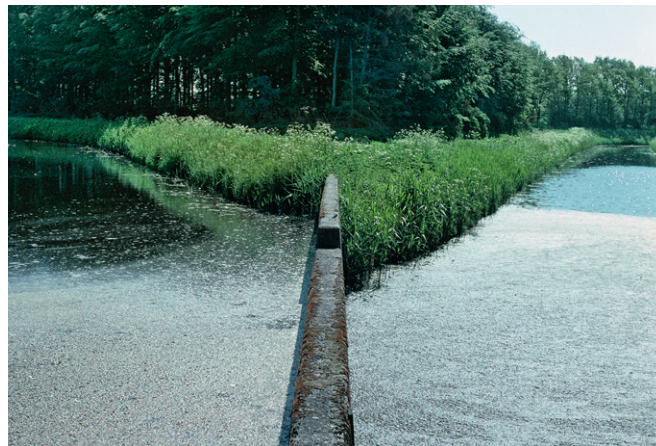
Marrebæk Pumpestation modtager vand fra to separate afvandingsystemer, der mødes helt fremme ved pumperne uden dog at løbe sammen. For det nordlige område er løftehøjden 2,8 meter og for det sydlige fire meter.
