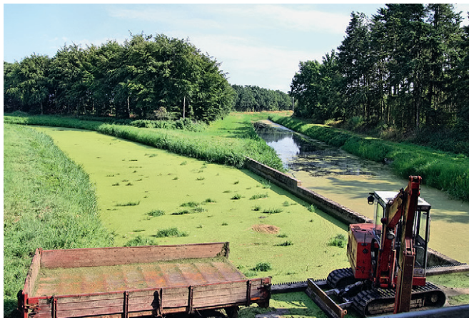
Marrebæk Pumpestation modtager vand fra to separate afvandingsystemer, der mødes helt fremme ved pumperne uden dog at løbe sammen. For det nordlige område er løftehøjden 2,8 meter og for det sydlige fire meter.
