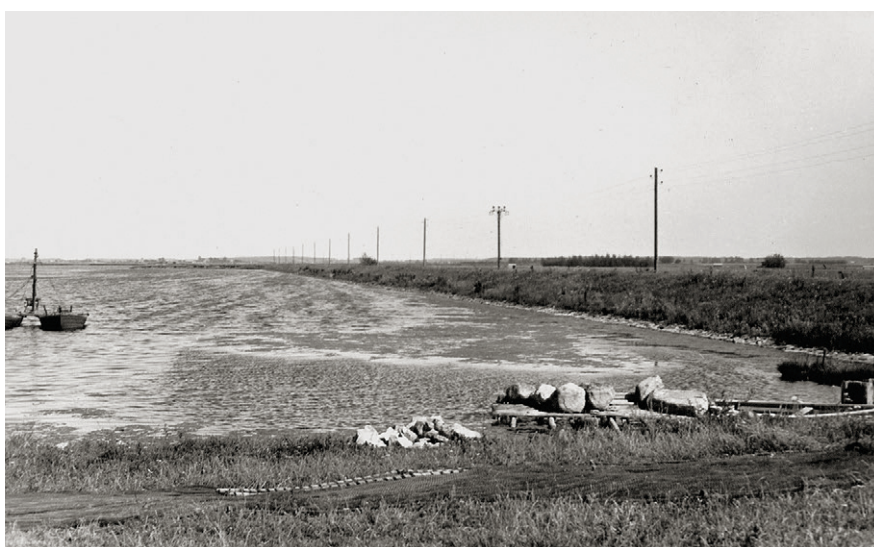
Centralkanalen gravede man med håndkraft, hvorimod den knap to kilometer lange dæmning blev bygget ved hjælp af tipvogne til at transportere det opgravede materiale. Lokomotivet hentede man selv på hestetrukken vogn i Saksøbing. Senere blev der også anvendt en flydende gravemaskine, der kunne deponere sit materiale på land ved hjælp af en lang slidske. Fotos: Saksøbing Lokallhistoriske Arkiv; nederst tv.: Einar Storgaard 1941.
