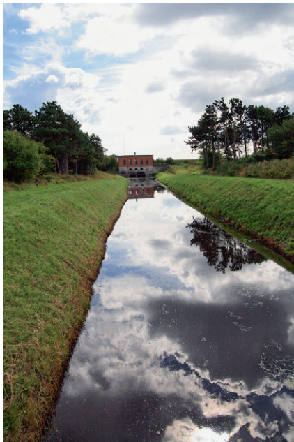
Den brede kanal op til Billitse Pumpestation fungerer som et pumpedbassin, hvor en vis mængde vand får lov at ophobes, før det pumpes ud.
