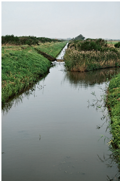
Gennem denne pumpekanal trækkes det okkerbelastede vand ud fra de smalle Sande (området med golfbanen) nord for Søndervig-vejen. De to dræned søer, Røjkliet og Humsø, holdes tørlagte ved udpumpning gennem »Brønden«, som er navnet på den kanal, der løber til fra højre. Billedet er taget mod nord fra pumpehuset, som er vist på forrige side. Foto: 8. okt. 2008.
