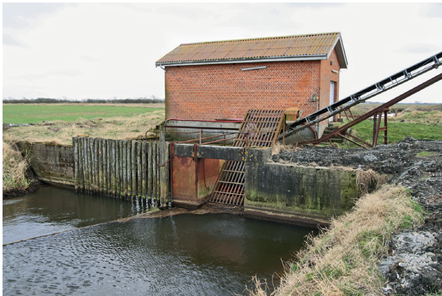
Pumpestationen er maskinrummet i det store anlæg, som holder egnen mellem Ingstrup, Vrensted og Tise nogenlunde fri for oversvømmelser. Huset er den klassiske model, som Hedeselskabet altid anvendte. Opført i røde mursten med indbygget frisluse og to stk. pumper med en kapacitet på hver 700-1000 liter i sekundet, som var leveret i 1952 af ingeniørfirmaet Myhrwold & Rasmussen i København.
