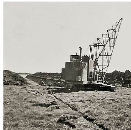
Statens millionstøtte til projektet var begrundet med ønsket om at skabe arbejde til de mange ledige i lokalområdet, og derfor indeholdt landvindingsloven et krav om udtrakt brug af manuel arbejdskraft. Alligevel blev der anvendt gravemaskiner til det meste af arbejdet med kanalerne i Ingstrup Sø. Foto: Ernst Boe.
