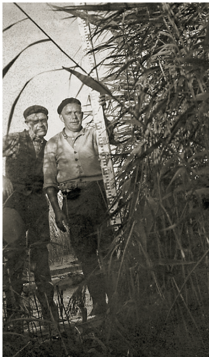
Landmålerfirmaet Birk og Boe I/S fra Hjørring gik i gang i 1950 med at nivellere ude i den mandshøje tagrørskov som forberedelse til den endelige tørlægning af Ingstrup Sø. Foto: Ernst Boe.
