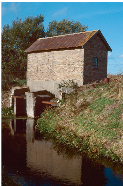
Det gamle pumpehus i gule sten ude ved Færgesborg løfter vandet fra den centrale hovedkanal 1-2 meter og op i den inddigede ringkanal, hvorfra det løber videre ud forbi Egebaksande og mod syd til Faddersbøl.
