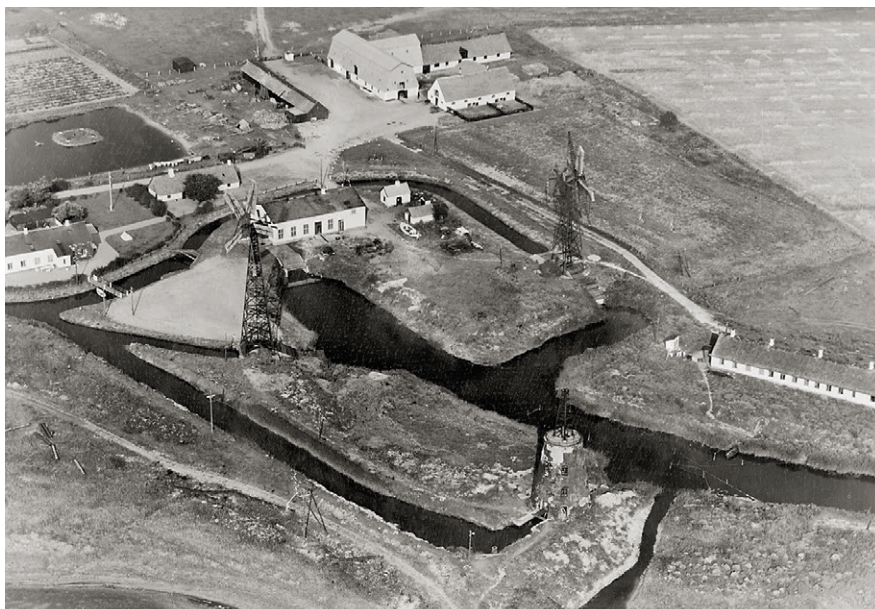
Set fra luften ses det sindrige design med tre indløb til pumpemøllerne, hvoraf de to klapsejlere på gittermaster stadig var i funktion i 1943, hvor dette lufffoto er taget. Derimod var den store hollandske mølle ikke længere aktiv. Foto:Kalundborg Lokalkativ.
