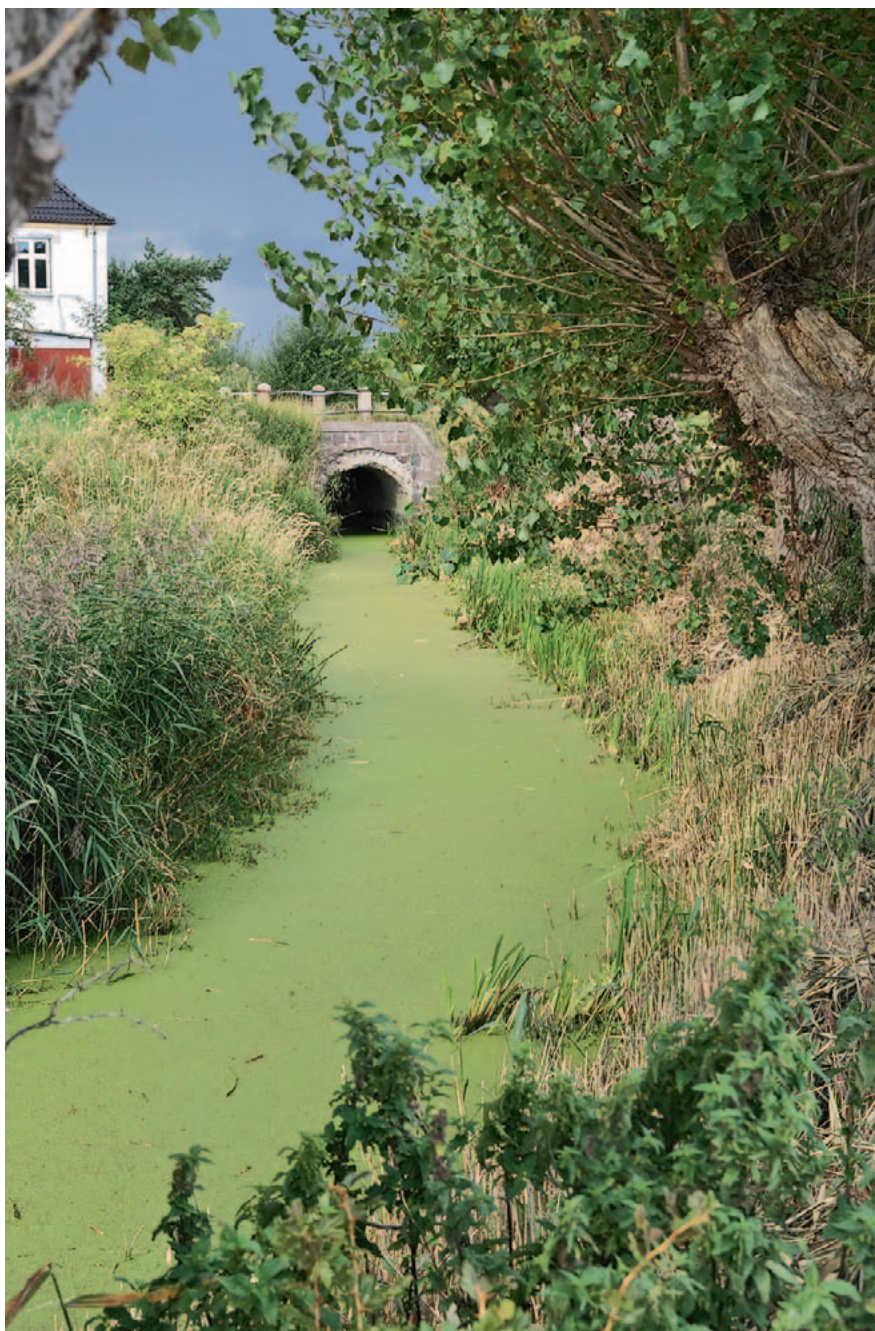
Idyllisk ser det ud med de gamle stynede popler langs landkanalen, der løber frem til slusen i Brøløkke-dæmningen, men drænvandets grønne farve afslører den voldsomme gødskning fra det intensive landbrug i Bund Sø. Den officielle begrundelse for at sætte Mjels Sø under vand var da også bekæmpelse af landbrugets forurening med kvælstof.
