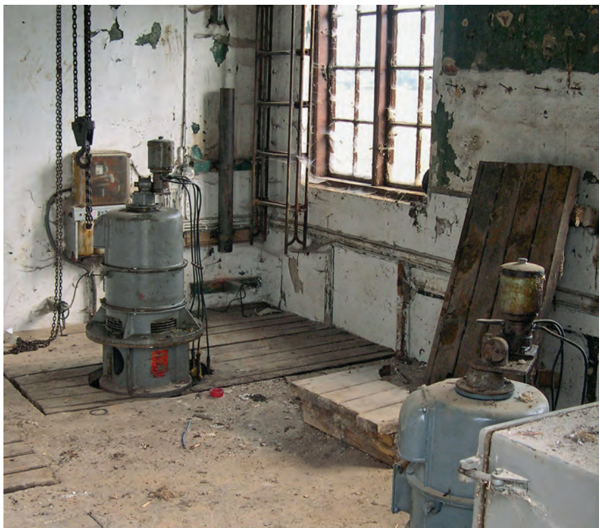
Pumperne blev fjernet og pumpehuset revet ned til sokkelen, da entreprenørmaskinerne rykkede ind i 2004. Derimod blev det gamle pumpehus fra 1928 istandsat og er i dag udstillingslokale og madpakkerum for gæster. Foto: Hans Jørgen Hvideland Olsen, Vejle Amt.
