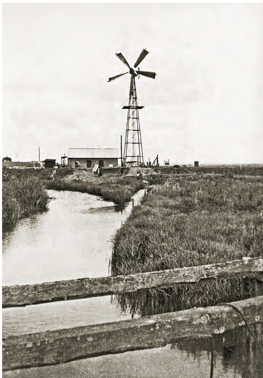
Den første vindmotor blev opstillet i 1923, en femvinget klapsejler af fabrikatet »Lykkegaard«. Den magtede dog ikke tilnærmelsesvis at pumpe tilstrækkeligt meget vand ud, så allerede i 1928 bygges der et pumpehus til en petroleumsmotor, der trak en såkaldt hollandsk pumpe. Foto: udlånt af Kolding Stadsarkiv.
